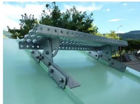
Berechnung für eine Stufe : 2 x Laufroststütze + Laufrost x Länge
